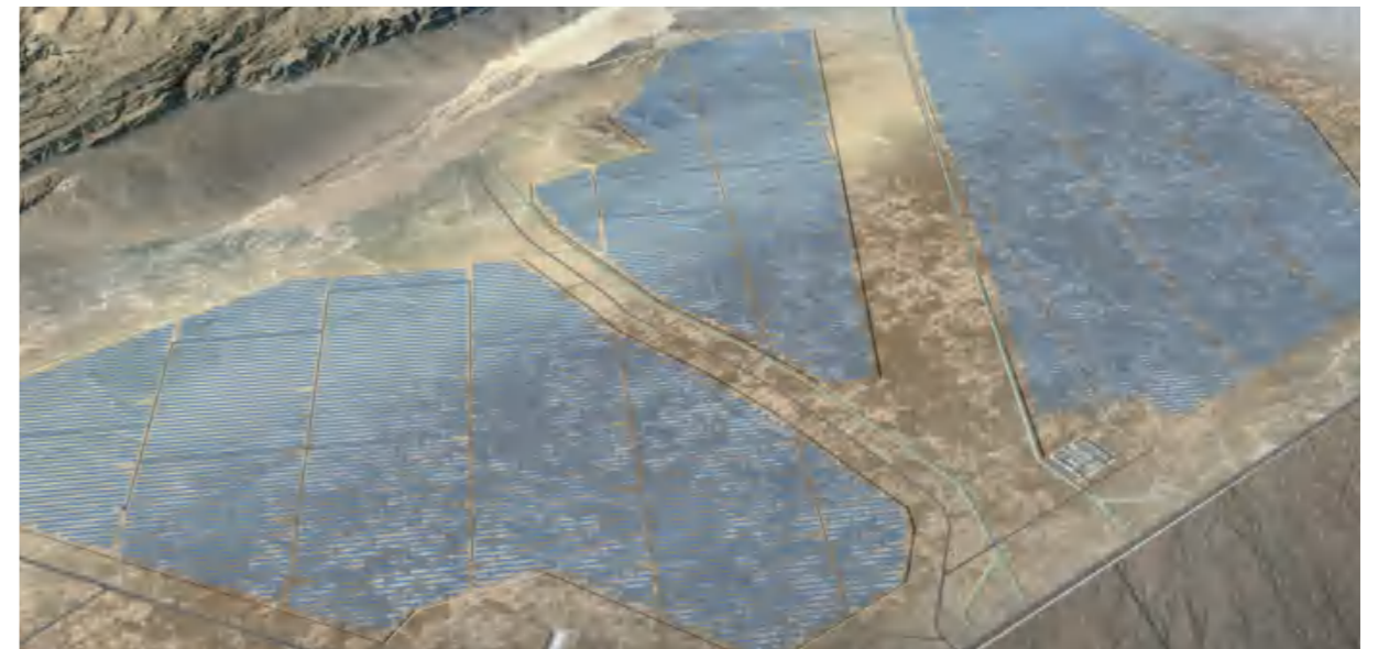
新疆光伏新能源项目，主要用于为新疆阿克苏地区工业园提供清洁能源，项目建成投产后，每年可发电 4 亿度，可直接减少超过 12 万吨用煤，减排二氧化碳 30 万余吨、二氧化硫 58 万余吨。
