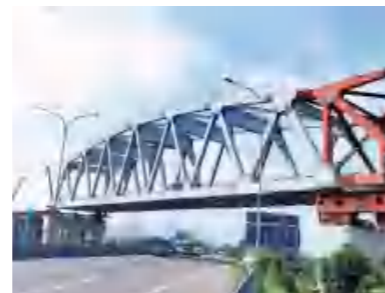
为印尼雅万高铁建造的 84 米钢桁梁
